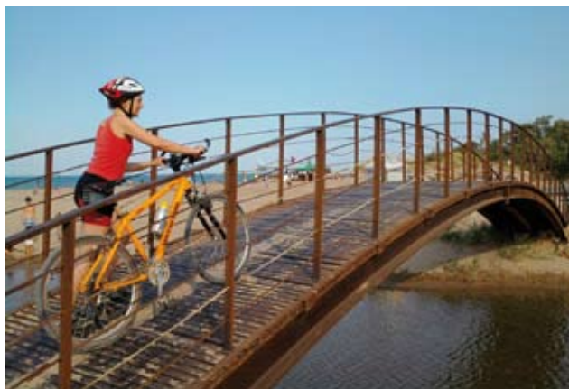
Pont sobre el Riuet
